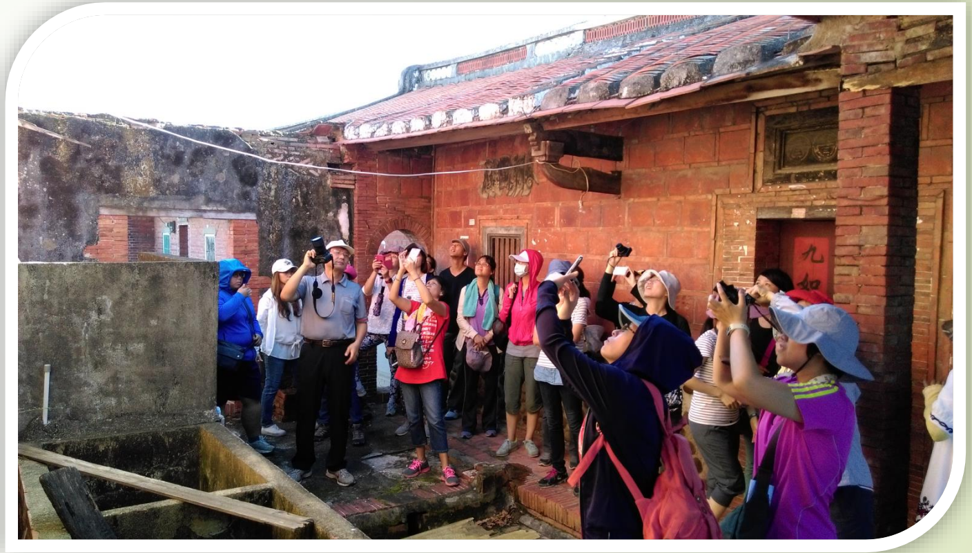
古厝內常見水的蓄水池兼做消防備用水
